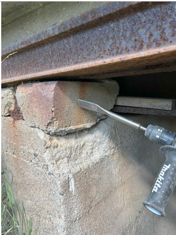
Figur 5. Landkar på vestre side av brua. Noe rustfarget i overflaten. Bilde: Sweco
