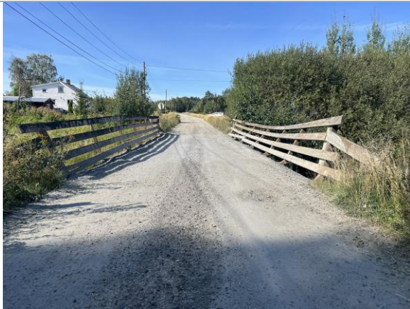
Figur 3. Bilde tatt fra østsiden mot vest. Merk hellende og skadet rekkverk. Bilde: Sweco
